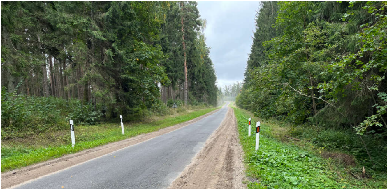
2 pav. Rekonstruojamas kelias Nr. 179
